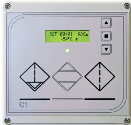
Наличие датчика точки росы (опция Н) позволяет перевести осушитель из режима переключения колонн по таймеру в режим контроля точки росы. В зависимости от нагрузки на осушитель, адсорбционный цикл может быть удлинен, то есть частота переключения сосудов будет адаптирована к текущей ситуации, и процесс регенерации будет производиться менее часто, что позволит снизить расход сжатого воздуха, т.е. затраты на электроэнергию.
